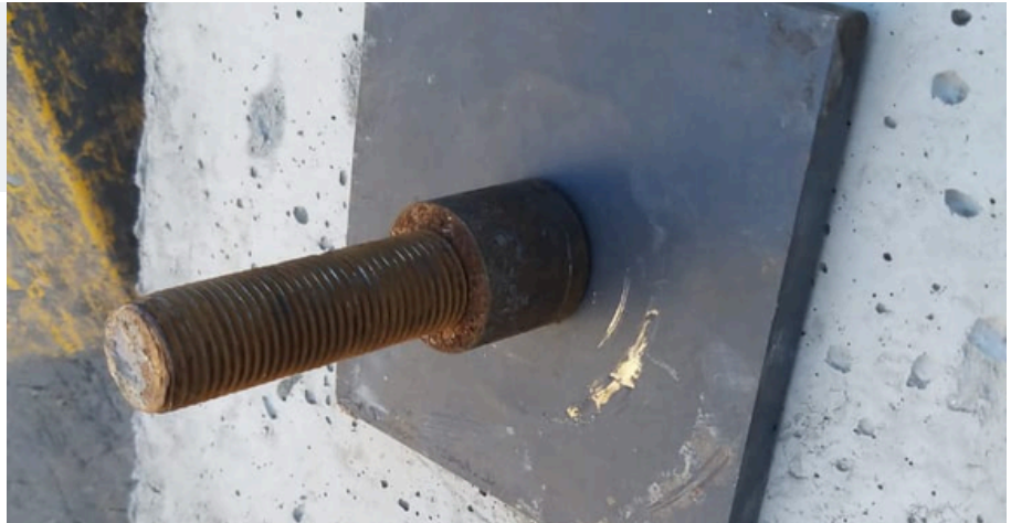
Anclajes pasivos o soil nail
