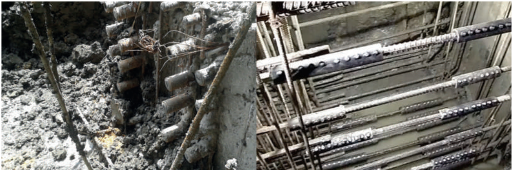
Vigas de Cimentación
