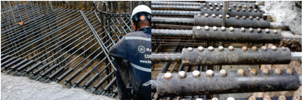
Repotenciación de Puentes
